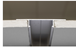
Aplicação em obra Aplicación en la construcción
