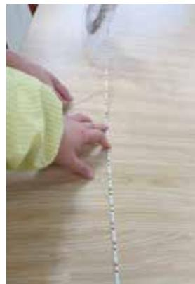
Se possível, a fita deverá ser aplicada por duas pessoas em simultâneo de forma a assegurar o correto percurso da fita e remoção da fita adesiva.
